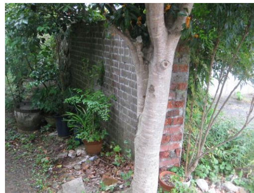
現在もガレージのレンガ壁が残っている
