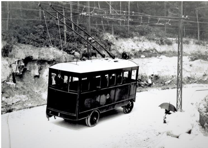
車掌がポールを直している (側柱と架線の状況 が良く分かる)
